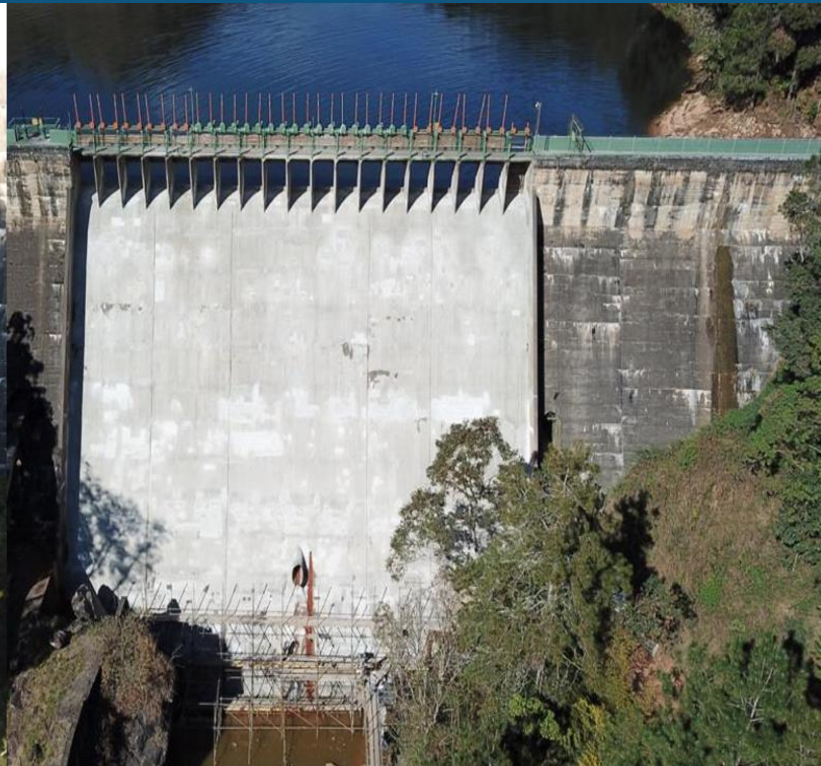
BARRAGEM PCH-REPI-WENCESLAU BRAZ-MINAS GERAIS
